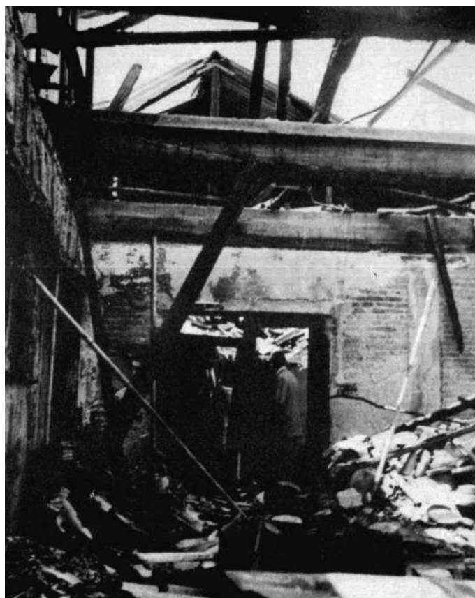
Figura 7 - Cinemateca Brasileira destruída por incêndio
